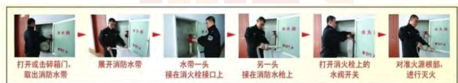
图 7.6: 消火栓使用方法
