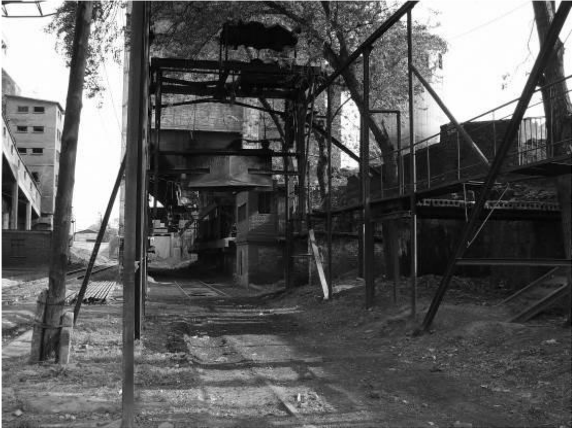
52、三里洞煤矿场景
