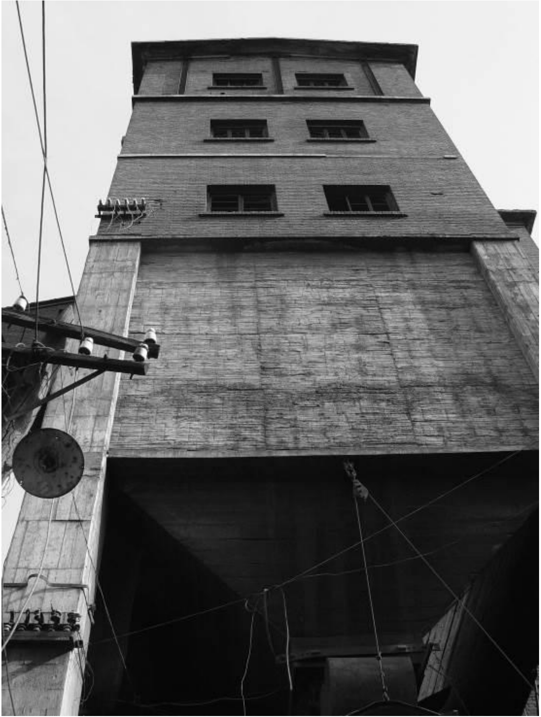
48、三里洞煤矿选煤楼
